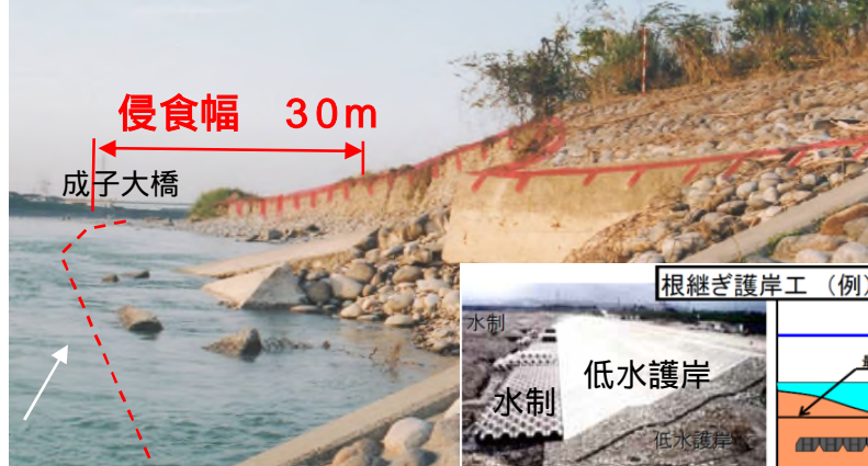
H16年10月洪水護岸欠壊 (R17.8k付近)
