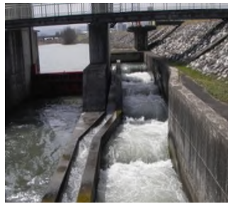
井田川合口頭首工（階段式）
