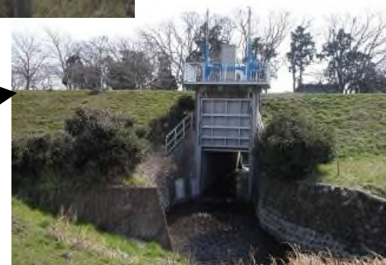
老朽化した施設の補修例 (松川舟通り水門 H19実施)
